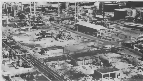
ALGUN DI e plantanan mas bieu di Lago a cal dilanti e poderio di ex- perimentacion. Bieu y cambiá, incapaz pa opera mes eficiente mas cu e plantanan moderniza di Lago, Visbreakers 11 y 12 y Combination Units 1, 2, 3 y 4 ta worde tumbá abao. E retratonan ariba ta muestra e planta- nan manera un tempo nan tabata y e escena cu nan ta brinda awendia.
